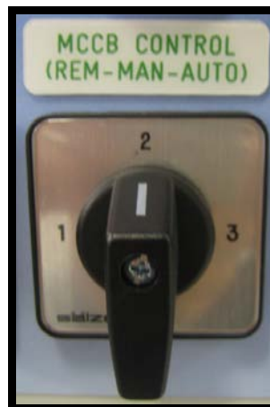
Рисунок 7-1. Переключатель режимов управления МССВ (-S6)
